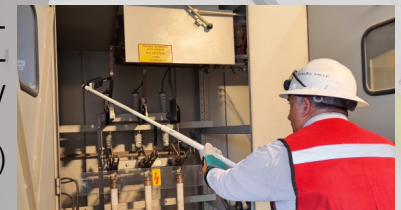
Metodología para dar mantenimiento a subestación
